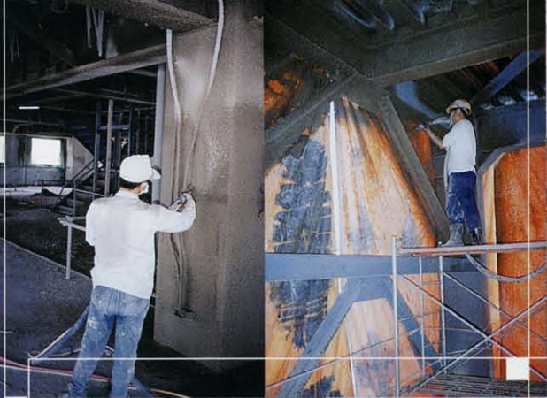
◀ 鋼樑噴塗 ▲ 方柱噴塗 ▼ 斜撐噴塗
