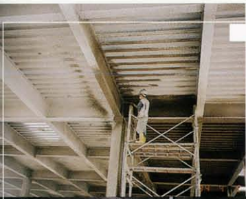
◀ 鋼樑噴塗 ▲ 方柱噴塗 ▼ 斜撐噴塗
